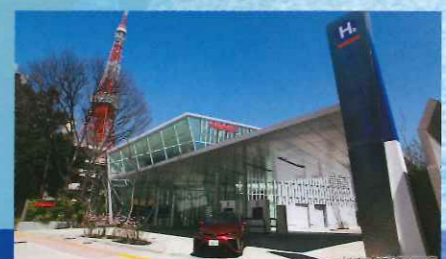
■ 水素ステーション
